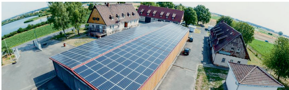
Fishmaster, Trebur-Hessenaue - Der Strom der 94 kWp Photovoltaik-Anlage wird fast vollständige in der Fischzucht verbraucht. Die 384 Hochleistungsmodulare erzeugen rund 100.000 kWh Strom im Jahr und vermeiden so 60 t CO 2 pro Jahr. Der Reststrom kommt von Lichtblick und rundet die Ökostrombilanz ab.
